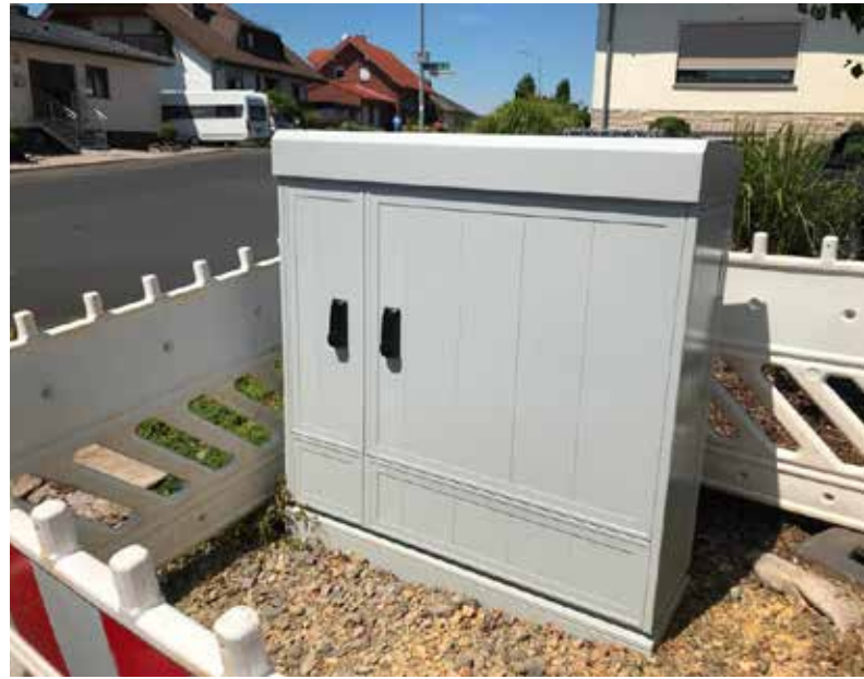
Über der Erde sind von Breitband nur Multifunktionsgehäuse sichtbar.
