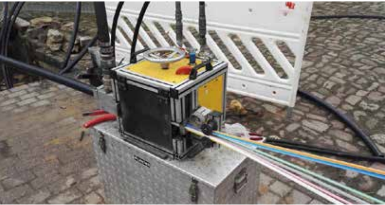
Diese Kabeleinzüge sorgen unter der Erde für eine flüssige Leitung. Foto: Breitband
